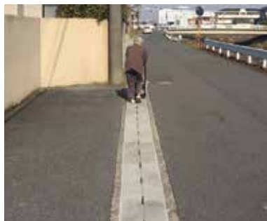
現場打ち側溝
