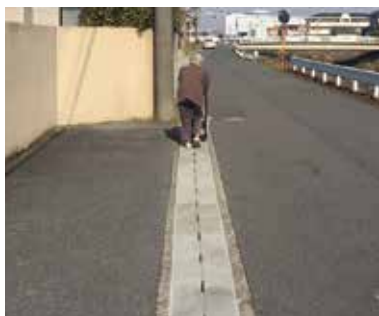
現場打ち側溝
