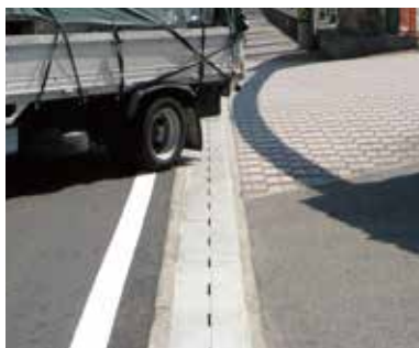
現場打ち側溝
