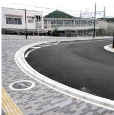
駅ロータリー整備 (兵庫県妻鹿駅)
