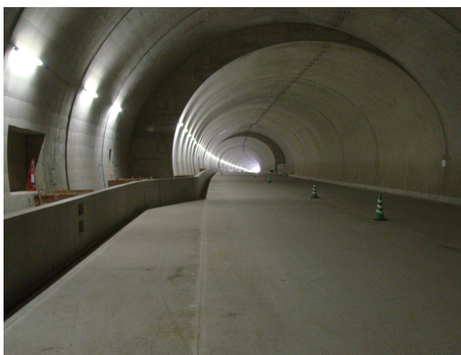
非常駐車帯①
