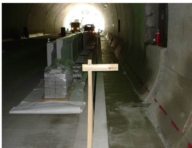
② 均しコンクリート打設
