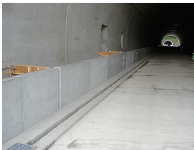
トンネル内部から出口を臨む
