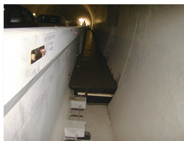
⑥ 底板コンクリート打設
