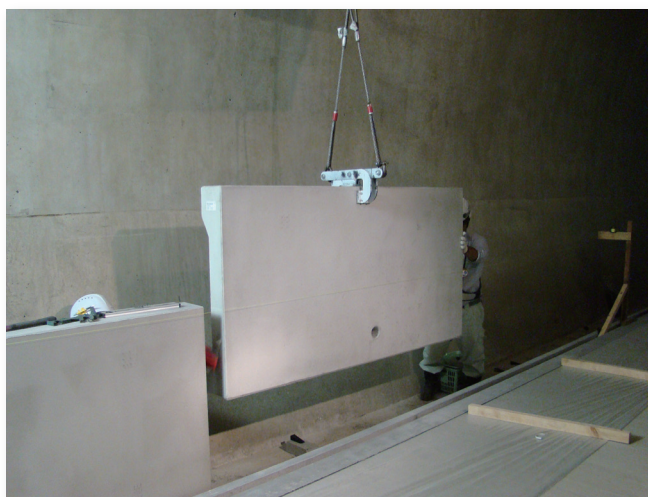
③ 専用吊金具にて据付作業
