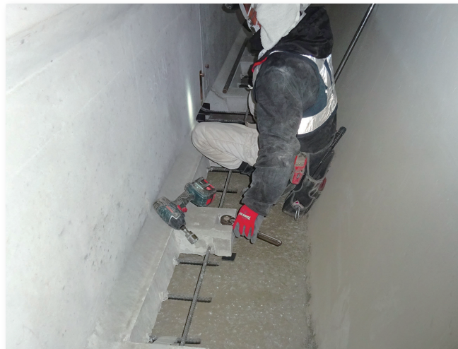
④ 製品据付 高さ調整
