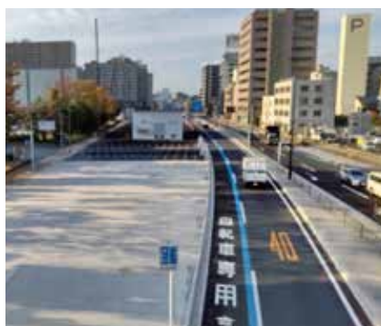
千葉国道事務所 千葉県千葉市
