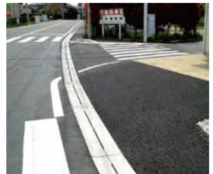
印旛土木事務所 千葉県佐倉市
