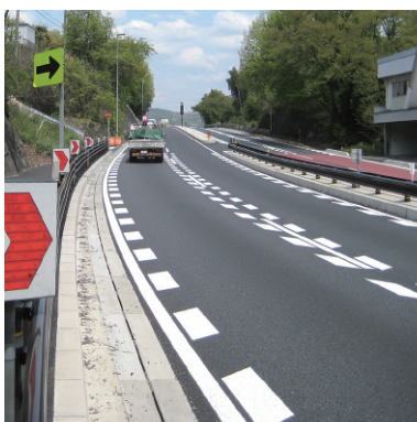
岐阜県土岐市(国道19号)
