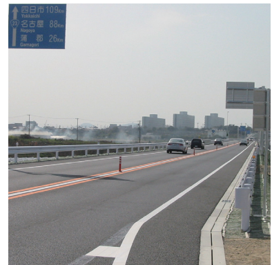
愛知県豊橋市(国道23号)
