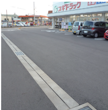
ドラッグストア(店舗駐車場)
