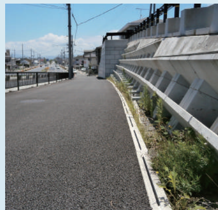
和歌山県和歌山市 南港山東線
