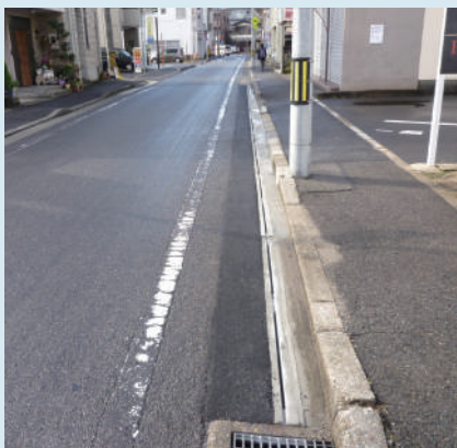
愛知県豊田市 道路維持修繕工事
