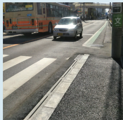
神奈川県横浜市 管内道路整備工事
