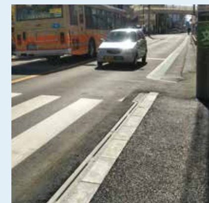
神奈川県横浜市 管内道路整備工事
