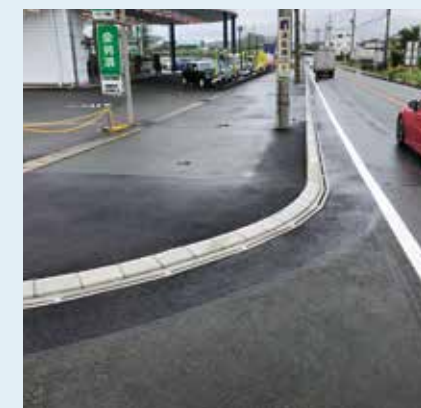
静岡県湖西市 国道301号
