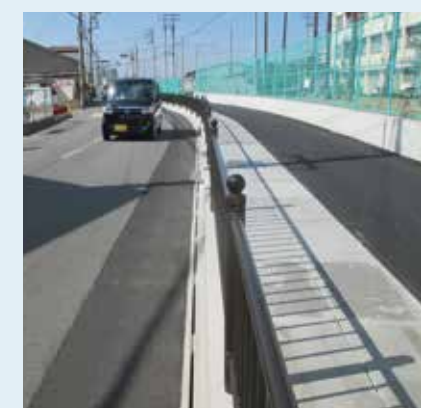
大阪府堺市 府道大阪高石線
