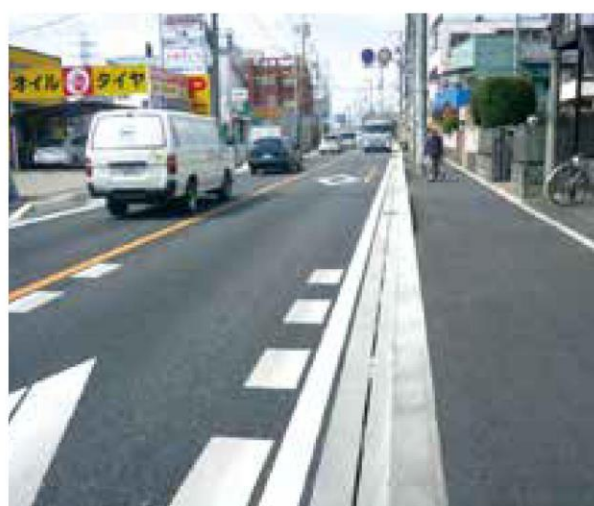
歩道整備事業 埼玉県朝霞市
