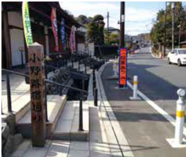
歩道整備 東京都町田市
