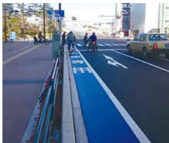
自転車レーン整備 神奈川県川崎市
