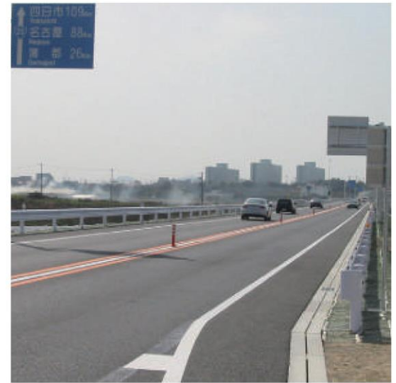
愛知県豊橋市(国道23号)
