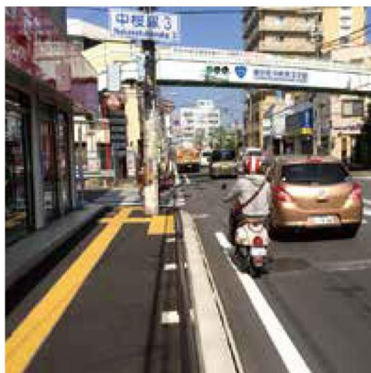
電線共同溝 (国道176号大阪府豊中市)
