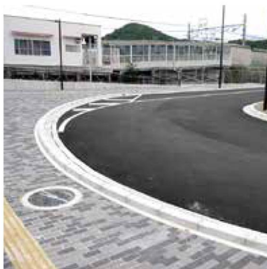
駅ロータリー整備 (兵庫県妻鹿駅)
