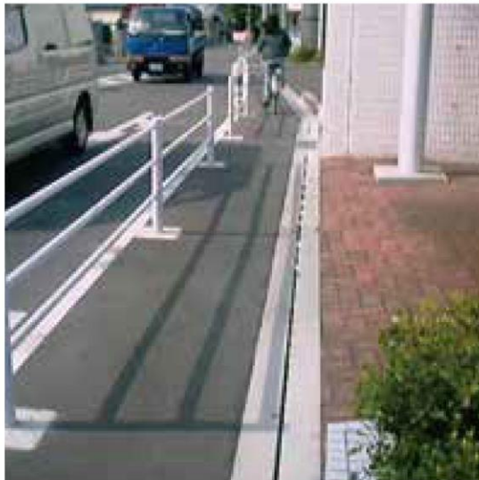
歩道整備事業 (大阪府阪南市)
