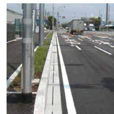
静岡県富士市(国道1号)
