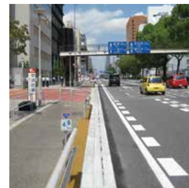
愛知県名古屋市(国道19号)
