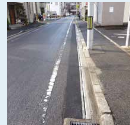
愛知県豊田市 道路維持修繕工事
