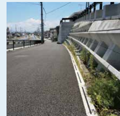
和歌山県和歌山市 南港山東線
