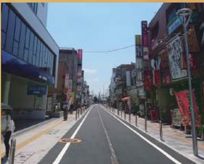
東京都昭島市 〈センター側溝〉
