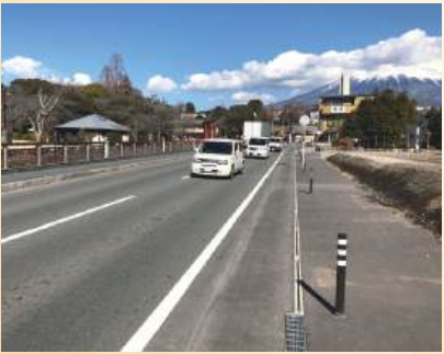
静岡県富士宮市 〈フラット歩道〉
