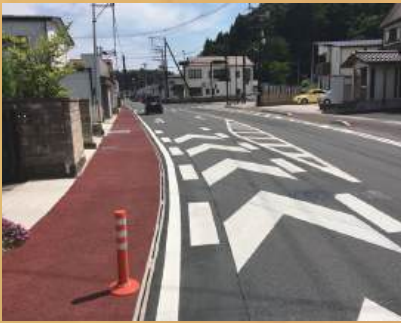
福島県白河市 〈歩道改良〉
