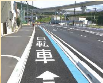
大阪府高槻市 〈自転車道〉
