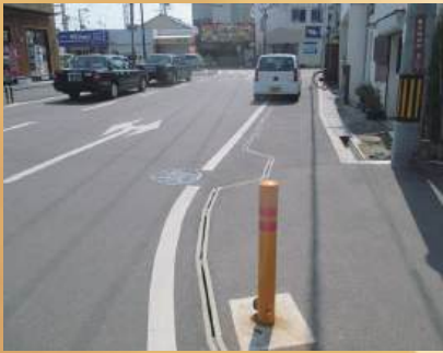
大阪府岸和田市 〈段差解消〉
