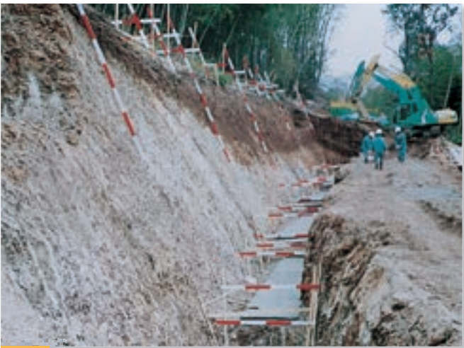
1 掘削・均しコンクリート打設
