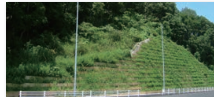
豊田市役所発注 豊田市四郷町地内
