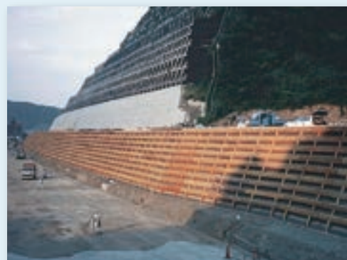
施工中 発注元: 日本道路公団 施工現場: 東名高速道路 [日本坂トンネル]
