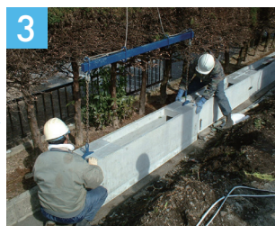
専用吊金属にて製品の据付
