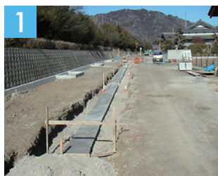
掘削をし、コンクリート基礎を打つ
