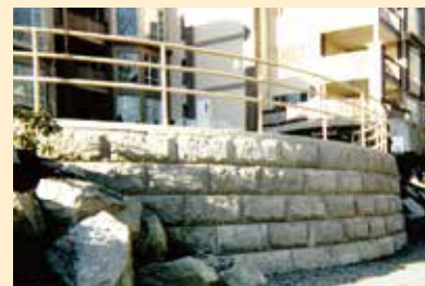
曲線部の施工
