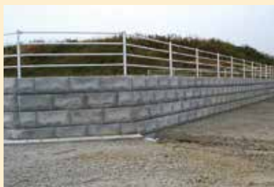
フェンスを立てる現場
